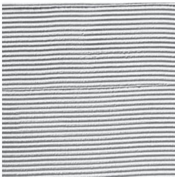
e. 鋸目(のこめ) ゴテ仕上
